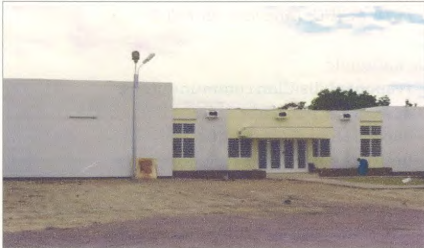
Bâtiment du Programme national de transfusion sanguine à Bandalugwa/ Kinshasa
